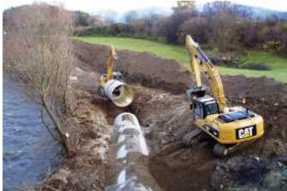
Die einzigartigen HOBAS GF-UP Druckrohre ergänzt durch das FWC Kupplungssystem erfüllen diese Anforderungen problemlos und so liefert HOBAS Rohre Österreich seit Oktober 2008 Druckrohre für das Kraftwerk Penz VAEE in
