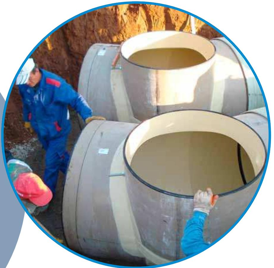
SewerLine® Rohren DN 1200 (PN 1, SN 10000) realisiert wurde. Es wurden zwei parallele Zwillingsleitungen mit einer Länge von jeweils 594 m (Gesamtlänge 1188 m) verlegt. Entlang dieser Leitungen fanden außerdem 16 HOBAS® Tangentialschächte und zwei Bögen DN 1200 ihren Einsatz.
