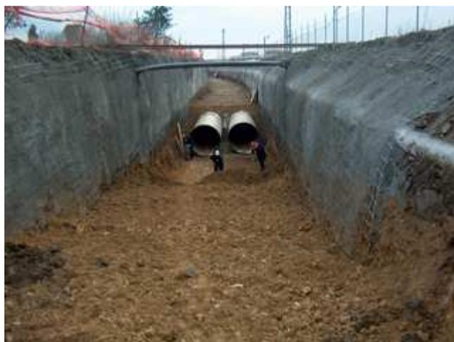
Der Hauptabwassersammelkanal transportiert das Abwasser zur Kläranlage von Stara Zagora und wurde als erstes erneuert. Zur Realisierung dieses Projektes wurden 2 Kilometer HOBAS Rohre DN 2000 (PN 1, SN 10000) per Bahn von HOBAS Tschechien angeliefert, weitere 380 Meter DN 800 (PN 1, SN 10000) kamen aus dem Werk
