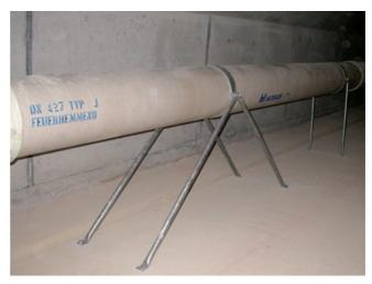
mit einer speziellen Harzschicht überzogen, wodurch eine glatte Rohroberfläche entsteht, die keine Ablagerungen aufnimmt und mit einem Wasserstrahl mit geringem Druck leicht zu säubern ist. Deshalb wurden zur Reinigung der Rohre neben der Entwässerungsleitung auch kurze, in Gegenrichtung verlaufende Spülleitungen
