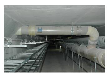
DN 200 eingebaut. Bei den Spül- und Kontrollöffnungen kamen eigens von HOBAS entwickelte, absolut dichte Spezialdeckel zum Einsatz, durch die Inspektionskameras in die Rohrleitung eingeführt werden können. Ein Schnellverschluss ermöglicht müheloses Öffnen ohne weiteres Werkzeug.
