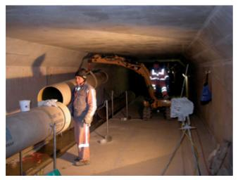
Die Arbeiten im engen Servicekanal forderten die Kreativität der HOBAS Techniker. So wurden die Rohre für die Entwässerungsleitung zu genau auf den Servicekanal abgestimmten Paketen geschnürt und dort von 2 Mann entladen. Ein Minikran wurde bei der Verlegung auf Pfeilern genutzt, um über die gesamte Länge ein
