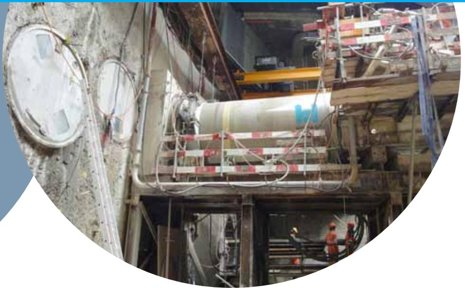
teilweise unter dem Fluss Limmat halbkreisförmig über dem späteren Tunnel vorgepresst. Anschließend wurden die Maschinen durch die Rohre zurück zum Startschacht geholt und die Rohrstränge mit Beton gefüllt. Dadurch waren die statischen Voraussetzungen geschaffen, um darunter den eigentlichen Eisenbahntunnel mit einem Durchmesser von 11,27 m zu bohren.
