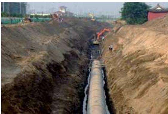
Die Stadt Yiwu entschied sich bei der Vergabe dieses Projekts aus einer Reihe von Gründen für die geschleuderten, glasfaserverstärkten Rohre von HOBAS. Der schon erwähnte weiche Boden macht den Einsatz von schwerem Gerät sehr aufwändig. Die geschleuderten GF-UP Rohre von HOBAS
