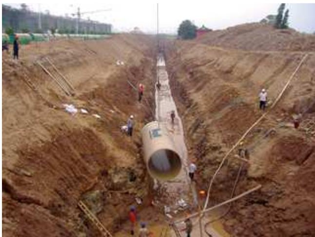
Der Bau dieser langen Rohrleitung wurde in drei Projekte aufgeteilt. Im ersten Teilstück wurden 2.257 m HOBAS Rohre DN 1200 bis DN 2000 verwendet; der zweite Abschnitt besteht aus 2.920 m HOBAS Rohre DN 800 bis DN 2000 und im dritten
