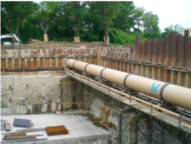
Kupplungen eingesetzt und auch die Stahlgürtel, die die Rohre fixierten, hatten eine Gummischicht. Aufgrund der möglichen tiefen Temperaturen wurde die Rohrleitung längs mit Heizdrähten ausgestattet und anschließend sorgfältig isoliert. Der restliche Teil der Leitung zwischen der Brücke und dem alten Kanal wurde erdverlegt.
