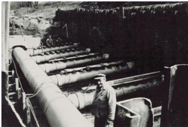
Von 1981 bis 1984 wurden in mehreren Schritten Rohrleitungen für die Abwasserentsorgung und den Abwassertransport zur Kläranlage eingebaut. Insgesamt 14 km HOBAS Rohre kamen hier zum Einsatz und wurden im offenen Graben, aber auch oberirdisch verlegt. Besonders interessant ist eben dieser oberirdisch montierte Teil der Rohrleitung. Er führt auf einer Rohrleitungsbrücke über den Fluss Ostrawitzka und leitet das Industrieabwasser zur Betriebskläranlage bzw. in ein Reservoir.
