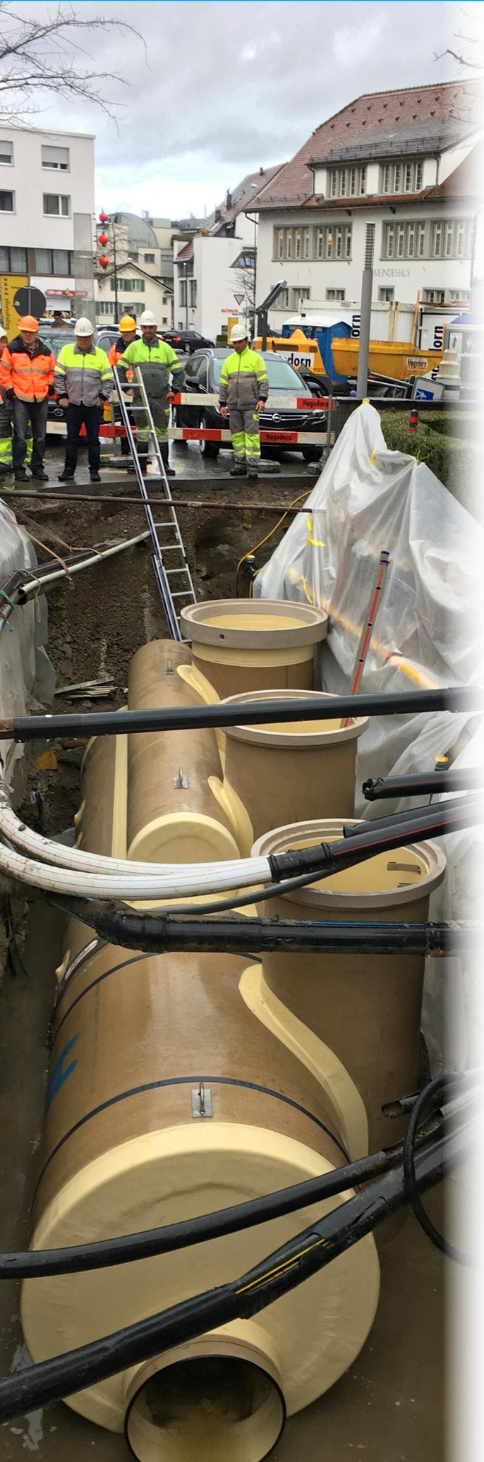
Die Bedingungen vor Ort erwiesen sich dabei als relativ komplex: Beengte Platzverhältnisse, eine hohe Frequenz an Passanten und viele längs und quer verlaufende Werkleitungen im Untergrund. Aufgrund dieser Umstände war ein flexibel anpassbares, rasch und einfach zu versetzendes Bauwerk notwendig. Nach eingehender Recherche möglicher Materialien und Varianten entschied sich die Gemeinde Freienbach für einen CSO Chamber aus geschleuderten GFK-Rohren von HOBAS.
