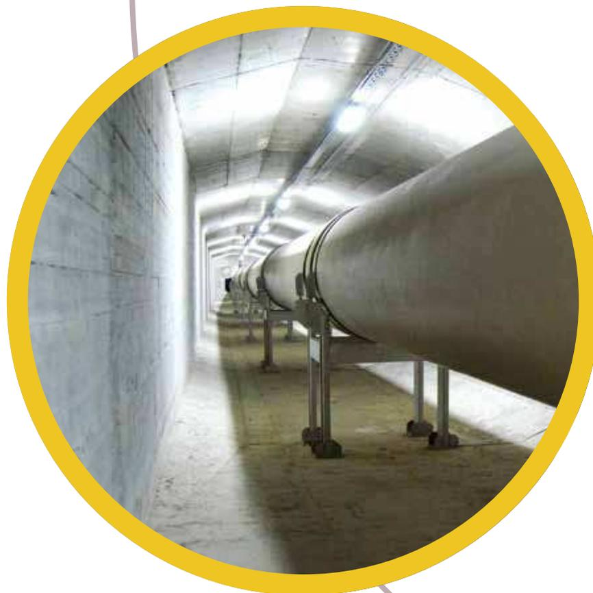
Alle Abschnitte der Rohrleitung wurden abschließend druckgetestet – einige sogar mit bis zu 9 bar. Vor allem für die Schächte stellte das eine harte Bewährungsprobe dar, da die Blindflansche DN 800, die ohne zusätzliche Hilfsmittel auf den T-Stücken montiert wurden, Kräften von bis zu 477 kN (48 Tonnen) standhalten mussten.
