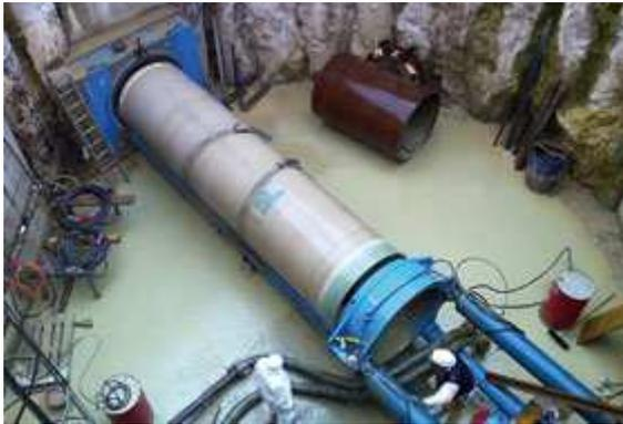
Um das Abwasser von Farnesina sicher zu entsorgen ließ die Stadtverwaltung von Rom einen Bypass zu zwei bereits bestehenden Betonkanälen DN 3500 bauen. Es sollte dort eine Rohrleitung DN 1400 mit einer Länge von 320 Metern entstehen.
