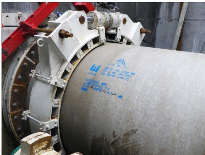
Unter der Lidoinself durch mit HOBAS Vortriebsrohren Der Meeresauslass ist insgesamt 20 km lang: 10 km davon führen von der Kläranlage Fusina zum Lido von Venedig und weitere 10 km von dort ins offene Meer, wo große Tankschiffe anlegen. Um die Lidoinself zu unterqueren, wurden 351 m Rohre DN 1400, PN 6 durch Vortrieb verlegt. Hauptauftragnehmer war die Baufirma Costruzioni Mantovani, die die Baufirma I.CO.P. SpA mit dem Bau der Rohrleitung betraute.
