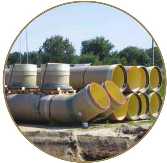
Bei den restlichen drei Vortriebsabschnitten ist das Vortriebsrohr gleichzeitig auch das Druckrohr. Für eine 24 m lange Kreuzung mit einer Hochdruckgaspipeline, eine 96 m lange Kreuzung mit einer Hauptstraße und eine 275 m lange 12 m tiefe Kreuzung mit einem Kanal und mehreren Straßen wurden die einzigartigen HOBAS® Druckvortriebsrohre OD 1099 und OD 1280 PN 6 mit FWC Kupplungen verwendet.
