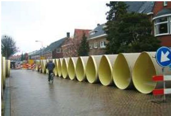
In den späten 90er Jahren wurde der Kanal durch darüber liegende Straßenarbeiten stark belastet. Untersuchungen mit Radargeräten zeigten Hohlräume neben dem Kanal. Durch Risse in der Kanalkonstruktion war hier Sand ausgewaschen worden. Einspritzungen mit Harz brachten nicht den gewünschten Erfolg; eine Sanierung war daher unumgänglich.
