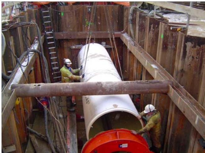
Dank des HOBAS Schleuderprozesses können alle Rohreigenschaften wie etwa die Steifigkeit exakt auf die geplanten Presslängen und die dazu benötigten Presskräfte abgestimmt werden. Dadurch werden Material- und Verlegekosten perfekt balanciert und die Gesamtprojektsumme optimiert. Die Kalkulationen wurden von HOBAS Benelux durchgeführt und dabei wurden
