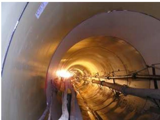
Kein leichtes Unterfangen für das Bauteam, aber mit den HOBAS GF-UP Rohren und der großen Erfahrung von HOBAS Polen im Vortrieb stellte auch ein Abstand von nur 60 cm zwischen U-Bahn und Kanal kein Hindernis dar.
