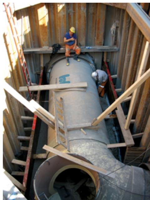
Die ausgezeichneten Ergebnisse der Sanierung veranlassten die Wassergesellschaft dazu, parallel zum Verlauf des alten ein zweites Abwassersystem zu errichten, um die Kapazität zu erhöhen. Kalkulationen des Projektteams zufolge erwiesen sich HOBAS GF-UP Rohre DN 2000 dabei als optimal für die zukünftigen Bedürfnisse.
