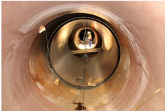
Der begrenzte Platz vor Ort machte für den neuen Bauabschnitt eine grabenlose Verlegung notwendig. Stahlrahmen wurden verwendet, um zunächst Stahlrohre DN 2300 zu verlegen. Diese bildeten den Mantel für die HOBAS Rohre DN 2000. Der Zwischenraum zwischen den Stahlrohren
