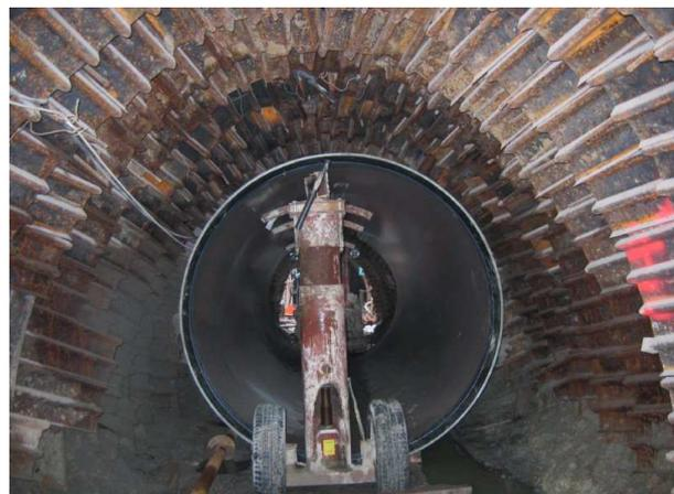
ihr geringes Gewicht und ihre einfachen Steckverbindungen die Installation erheblich vereinfacht haben. Sogar größere Durchmesser konnten auf diese Weise leicht ausgerichtet und verbunden werden. Leichte Handhabung, einfaches Verbinden und dimensionale Präzision bestätigen dabei, dass HOBAS GFK-Rohre die richtige Wahl waren.
