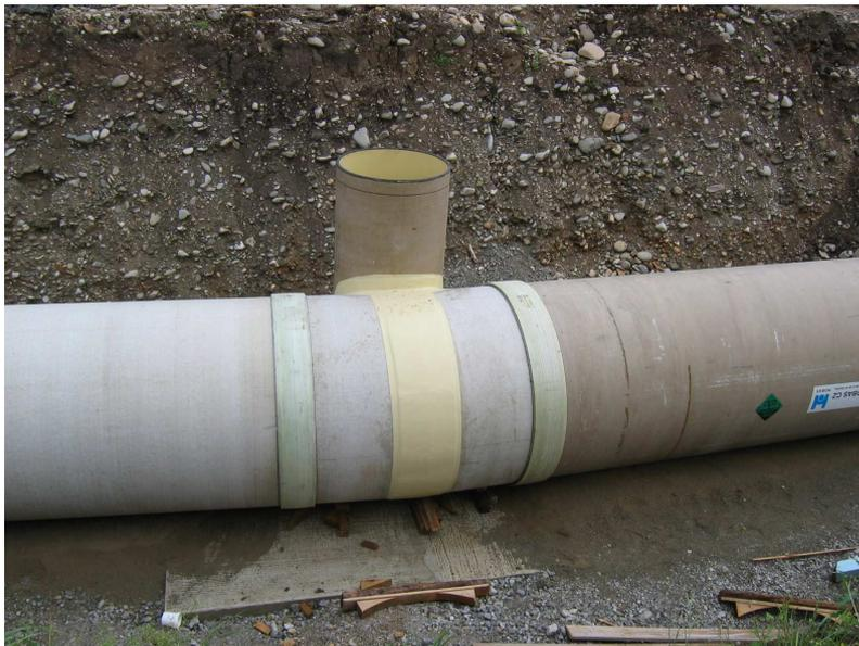
Die Grabenbauweise wurde dabei für ein Teilstück gewählt, wo der Verkehr dadurch nicht behindert würde. Das Rohrbett und die Zonen um die Rohre wurden mit Kiessand gefüllt und verdichtet. Jener Abschnitt mit starkem Verkehrsaufkommen wurde
