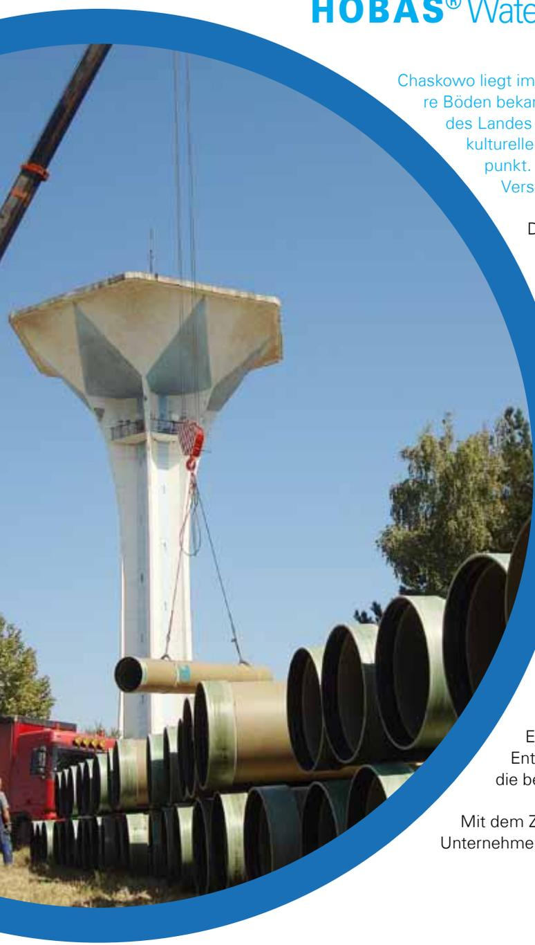
Rohre und Formteile der Druckklasse 10 bar. HOBAS punktete dabei mit überzeugenden Produktvorteilen: Bei der spiegelglatten Innenfläche der Rohre haben Bakterien keine Chance und gleichzeitig sind die Fließeigenschaften optimal. Außerdem ermöglichen das relativ geringe Gewicht der Rohre und die vormontierten Kupplungen eine schnelle und einfache Verlegung. Die hohe Qualität und die lange Lebensdauer von bis zu 100 Jahren machen die HOBAS Produkte zudem zu einer sehr wirtschaftlichen Lösung.
