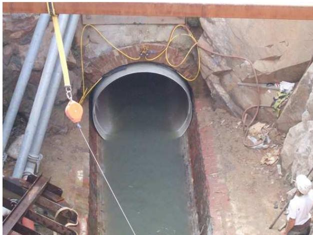
Das Bauunternehmen Metcalf & Eddy analysierte die Beschaffenheit des vorhandenen Kanals, um die Größe des innen liegenden HOBAS Rohres zu maximieren. Der Innendurchmesser des Ziegelkanals schwankte je nach Position zwischen 1850 und 1900 mm und wurde schließlich mit 110 m HOBAS GFK-Rohren mit einem
