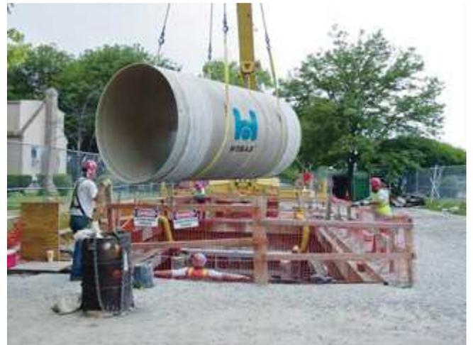
Die ersten 610 m des Verlaufes wurden mit HOBAS Relining Rohren OD 2900 mm saniert. Für die restliche Strecke erforderte der schlechte Zustand der alten Rohrleitung den Einsatz von HOBAS Rohren OD 2740.
